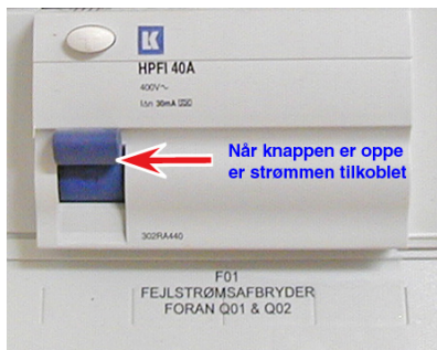
Fig. 2 til eksempel 2.1: Eksempel på fejlstrømsrelæ
