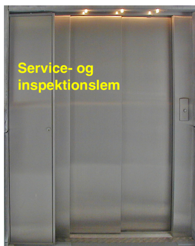
Eksempel på illustration til servicemedarbejder (elevator)
