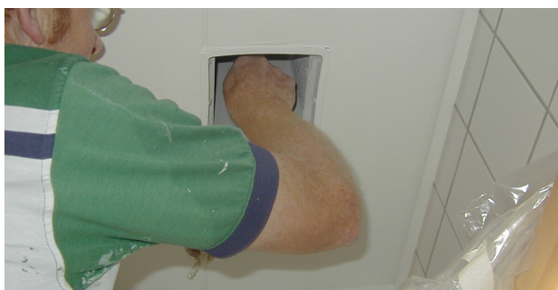
Fig. 3 Kanalen rulles med TM Coating ECO - Therm Energy.
