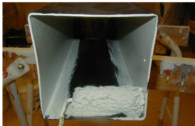
Fig. 2 Kanalen er behandlet med TM Coating ECO - Therm Energy, efter der er anvendt primer.
