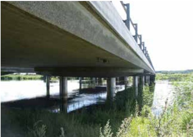
Stålbros og motorvejsbro over Gudenåen
