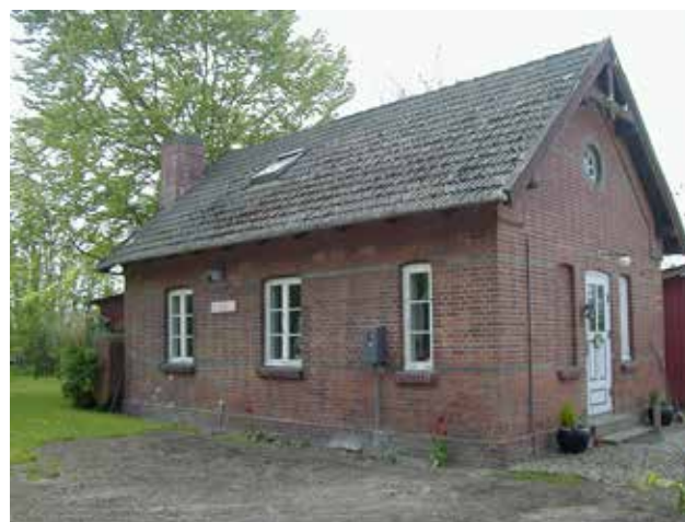
Østerbølle holdeplads (nord for Ålestrup)
