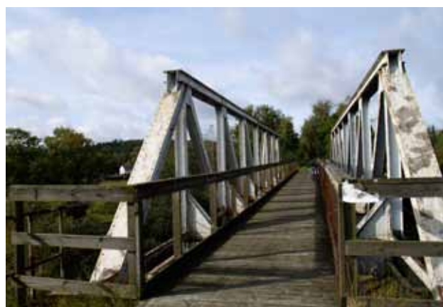
Jernbanebro over Funder Å og jernbanelinjen Silkeborg - Herning
